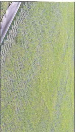
Des dalles en polypropylène pré-ensemencées seront mises en place aux sorties des habitations.
