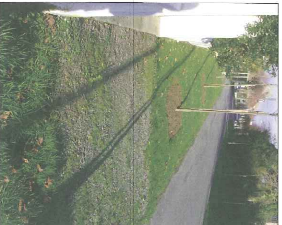
Ici, l'empierrement des accotements a été remplacé par une couche pierre (0/315) mélangée à de la terre " fine ". Un semis a été réalisé pour favoriser la pousse de l'herbe.
